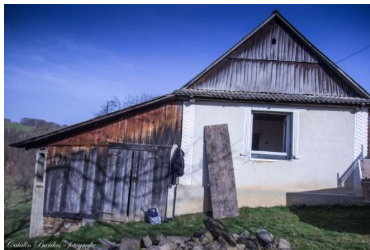
Lavori in corso
